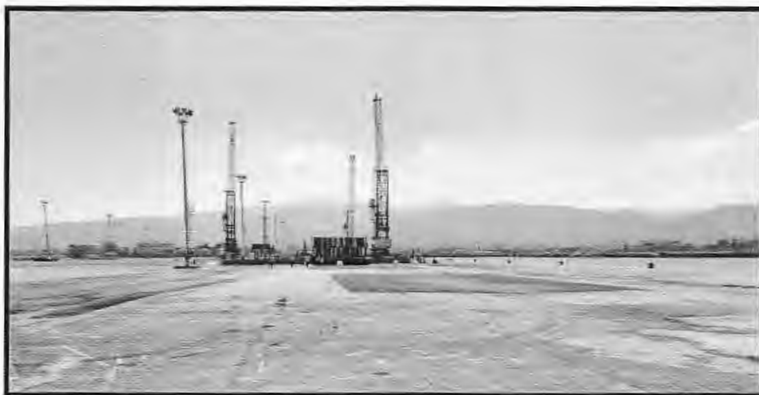
Figura 9 - Altre parti oggetto di bituminazioni
