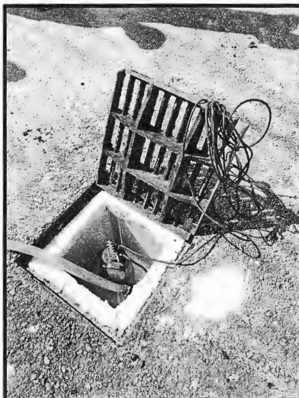
Figura 5 - sistema di smaltimento delle acque
