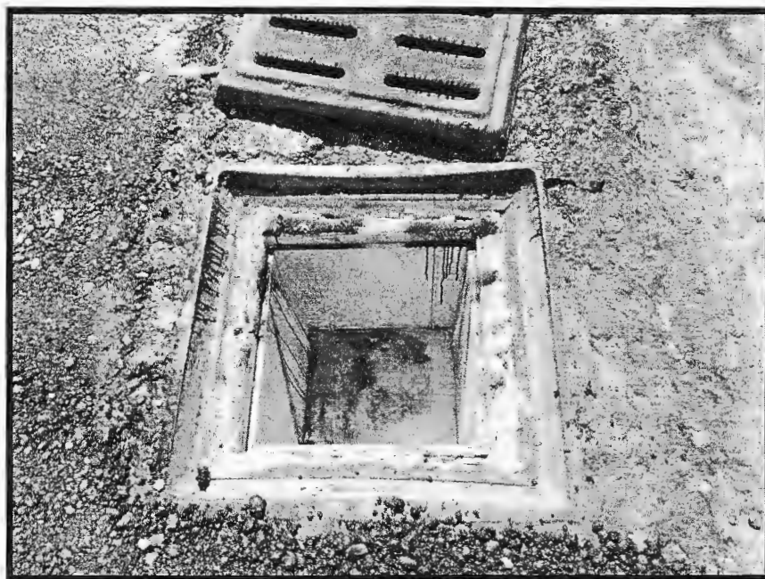
Figura 4 Pozzetto in pvc a tenuta stagna
