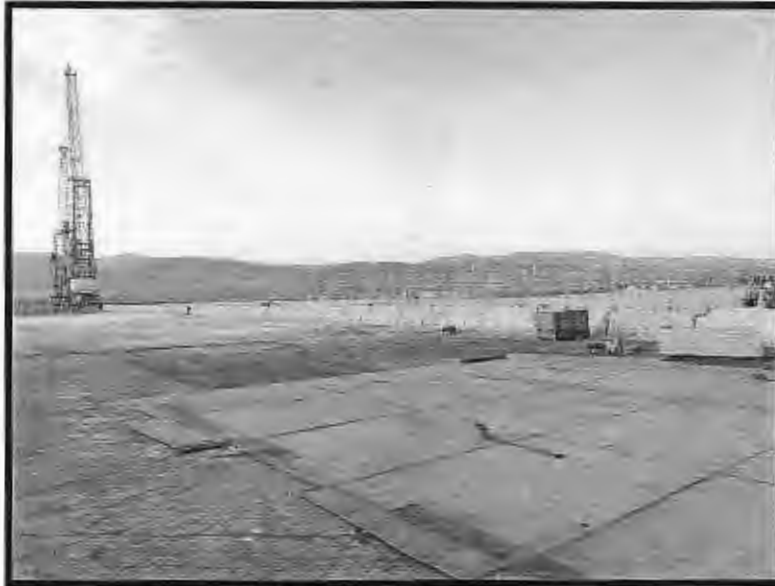
Figura 6 - Lamiere per protezione manto bituminoso
